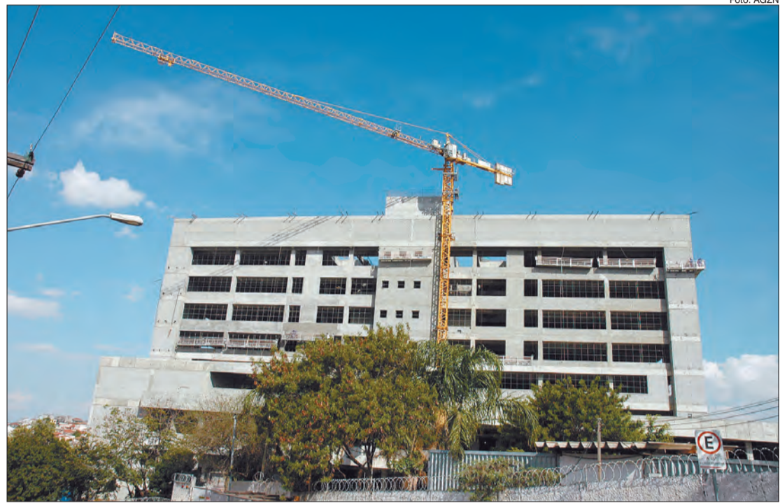
Hospital da Brasilândia tem obras aceleradas e inauguração anunciada para 2019
