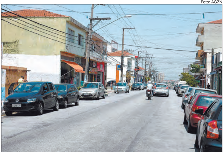
Avenida Nossa Senhora do Loreto reúne grande parte do comércio e serviços do bairro
