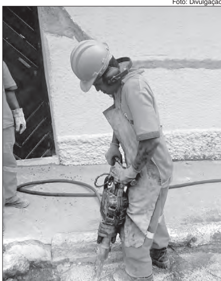
Reforma de Sarjeta na Rua Clóvis Salgado - Jardim Cachoeira
