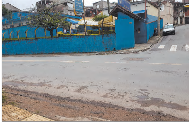
Falta faixa de pedestre em frente ao colégio
