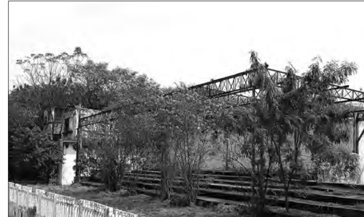
Antigas arquibancadas da Sociedade Paulista do Tiro ainda podem ser vistas no parque
