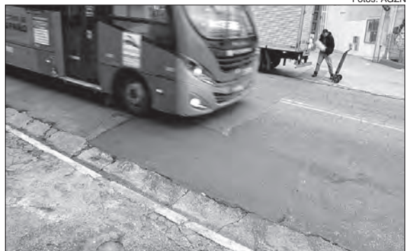
Cerca de um mês após a primeira publicação na AGZN, serviço concluído pela Subprefeitura Casa Verde/Cachoeirinha
