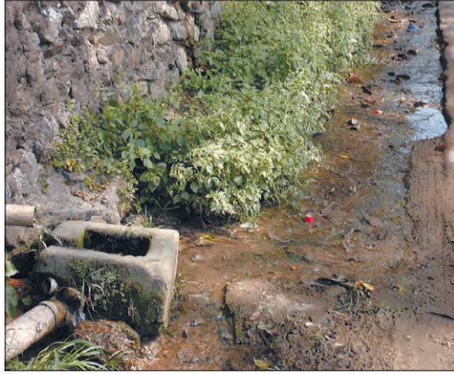
Obras da Sabesp no bairro têm previsão para o segundo semestre de 2020
