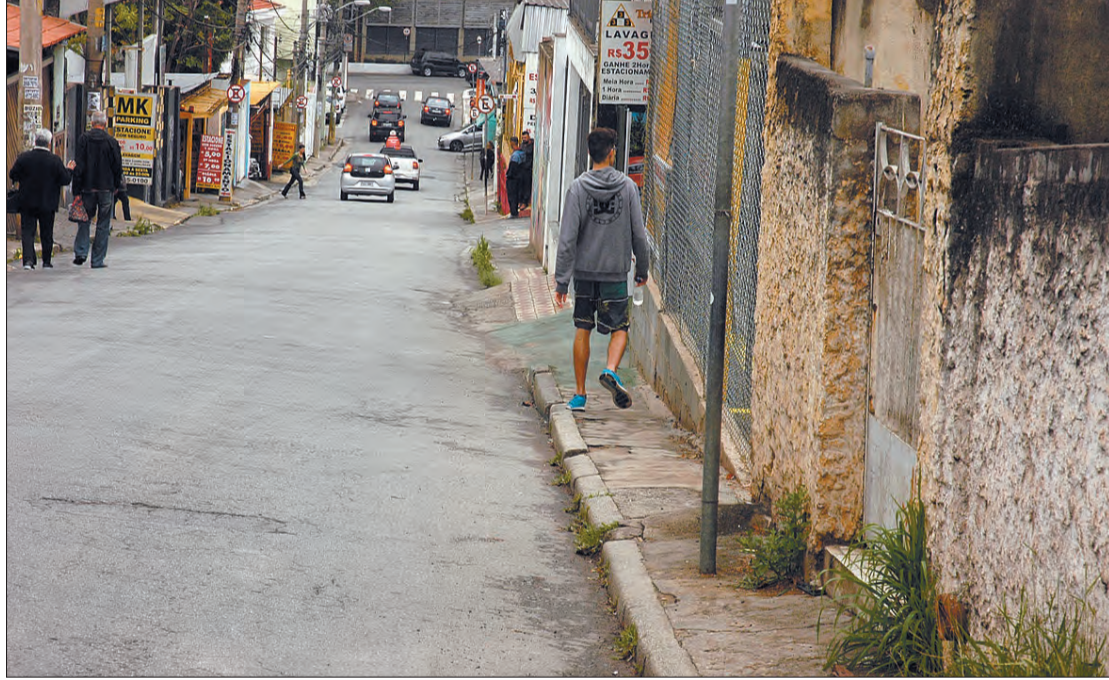
Falta de calçadas expõe pedestres ao perigo na Rua Inglesa
