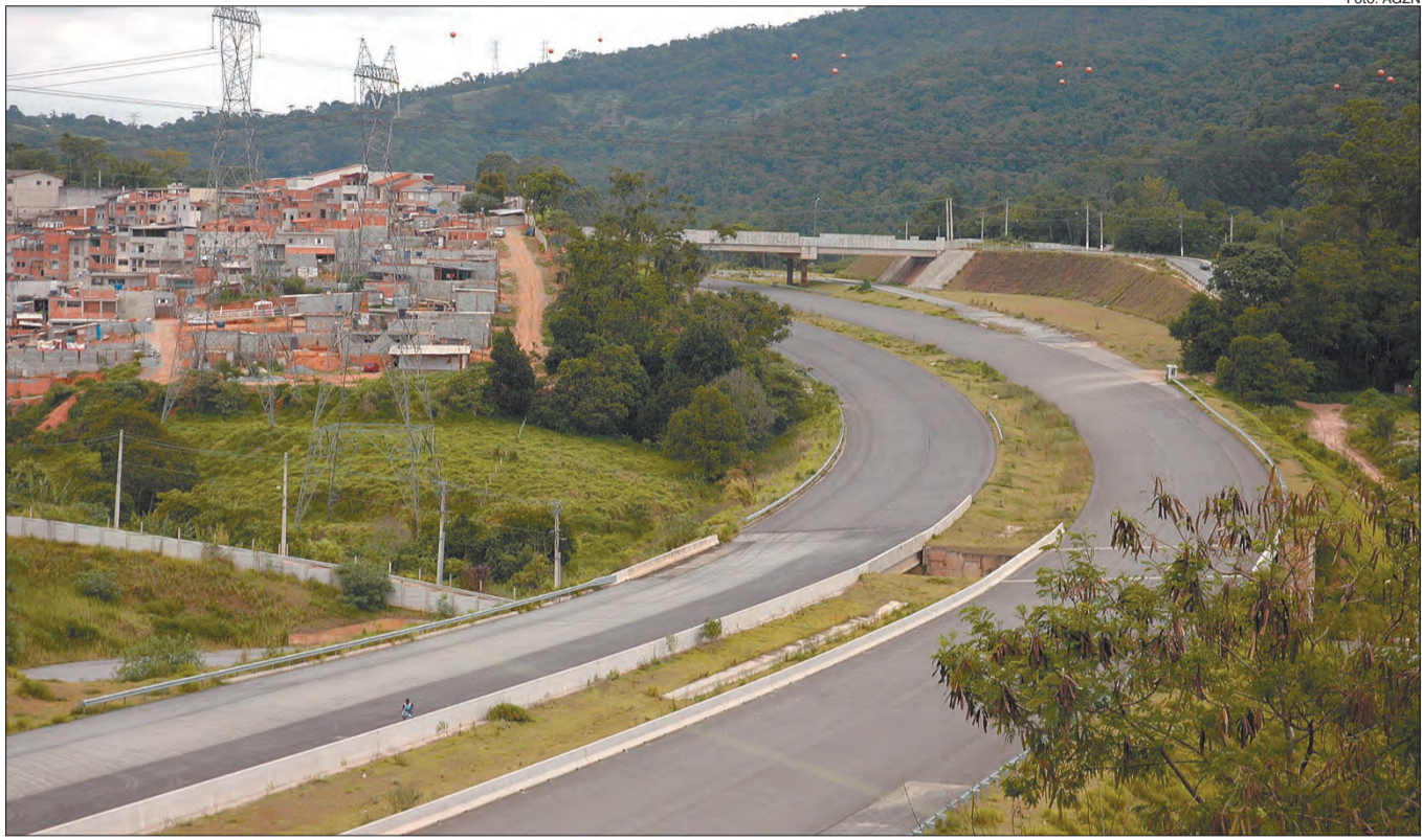
Rodoanel Trecho Norte tem obras totalmente paradas desde março deste ano
