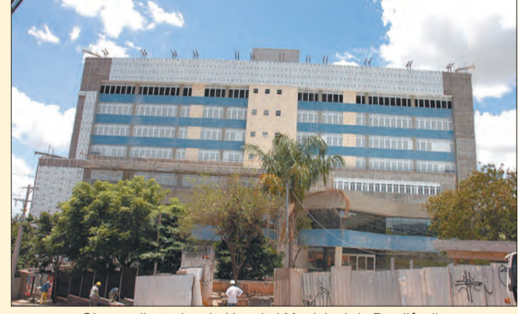
Obras adiantadas do Hospital Municipal da Brasilândia
