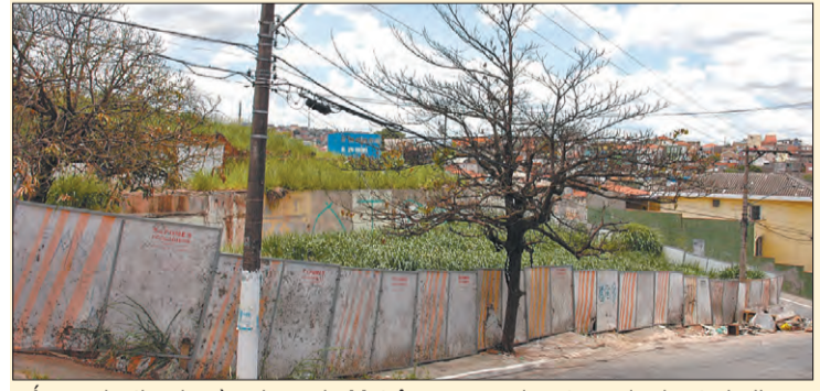
Áreas destinadas às obras do Metrô a espera da retomada dos trabalhos
