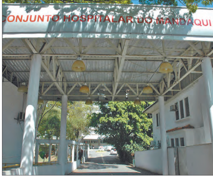
Pronto Socorro do Hospital do Mandaqui permanece fechado para reformas desde novembro de 2019
