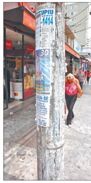
Postes aparentemente mal conservados chamam atenção de pedestres
