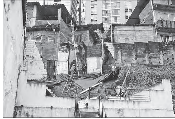
Desabamento de muro atinge acesso às residências na Rua José Debieux
