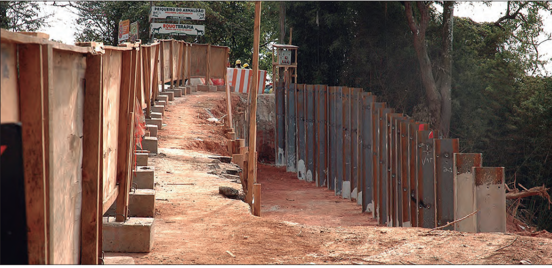
Fase de instalação dos perfis metálicos
