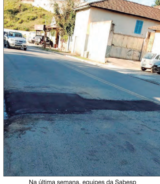
Na última semana, equipes da Sabesp estiveram no local e repararam o problema
