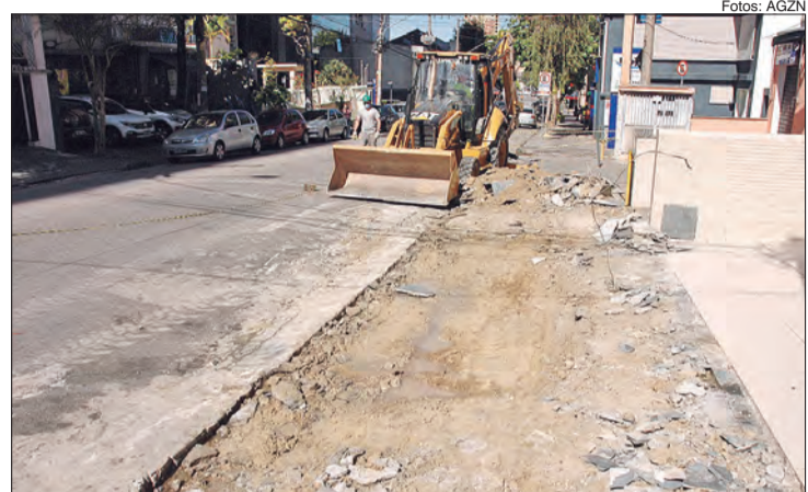
Obras de requalificação das calçadas em andamento na Rua Salete, em Santana
