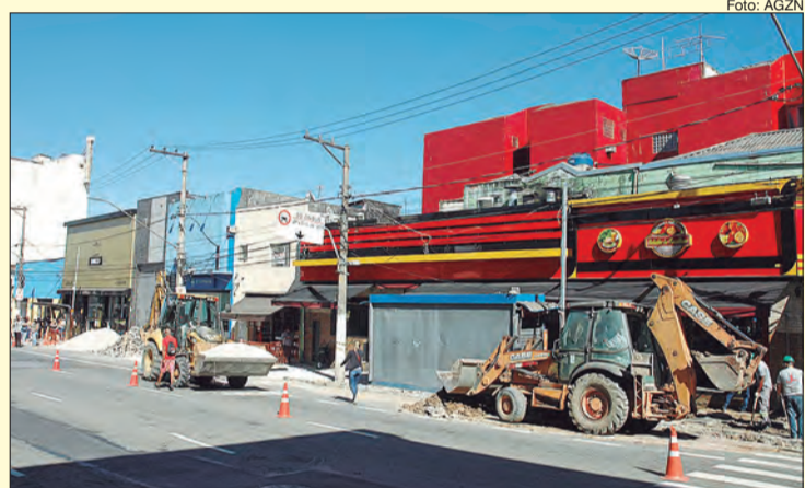
Diferentes pontos da Avenida Cruzeiro do Sul estão em obras
