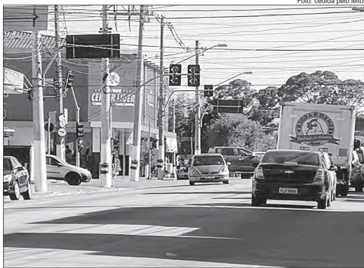
Ausência de placas de limite de velocidade e faixas na pista, prejudicam a segurança na Rua Abílio Pedro Ramos
