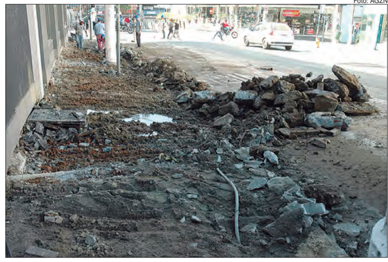
Obras de requalificação das calçadas na Rua Alfredo Pujol, em Santana
