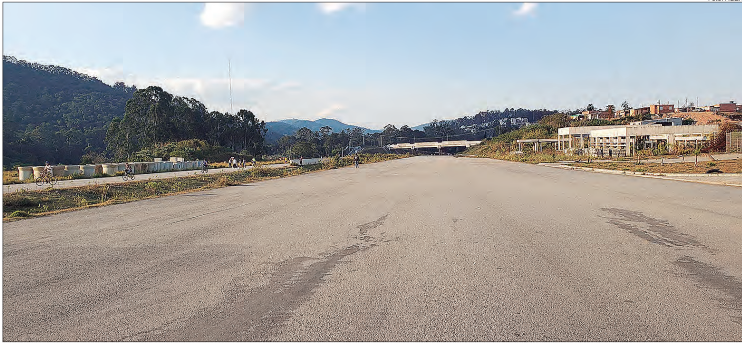
Dividida em 6 lotes, obra deve ser concluída em até dois anos após início dos trabalhos
