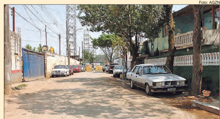
Rua Pedranópolis aguarda pavimentação há mais de 50 anos
