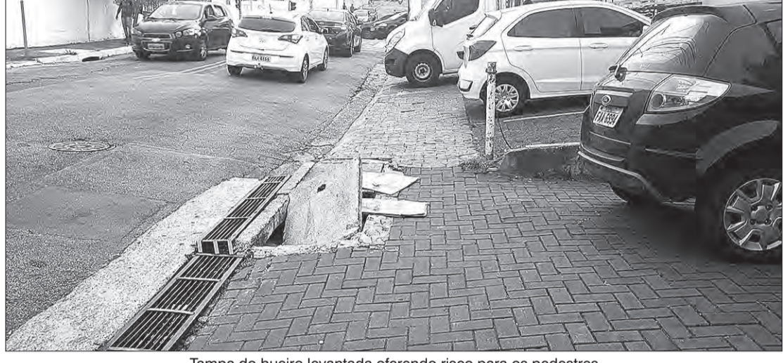
Tampa do bueiro levantada oferecendo risco para os pedestres
