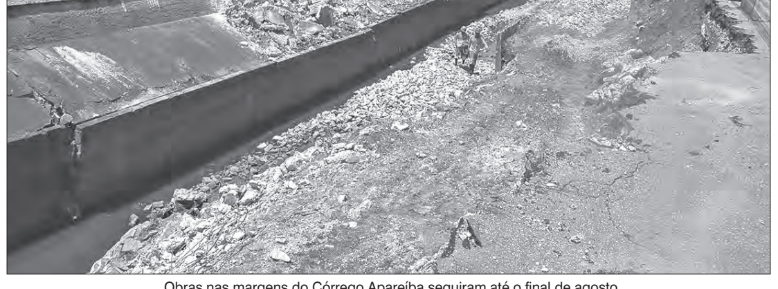
Obras nas margens do Córrego Apareíba seguiram até o final de agosto
