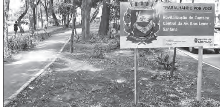
O Trecho do Canteiro Central da Avenida Braz Leme recebeu obras de revitalização
