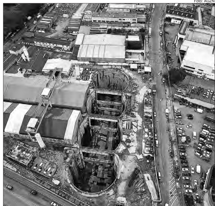
Canteiro de obras da Linha 6-Laranja do Metrô
