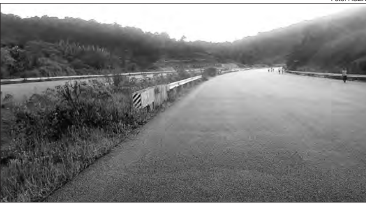
As obras do Trecho Norte do Rodoanel não têm previsão de retomada
