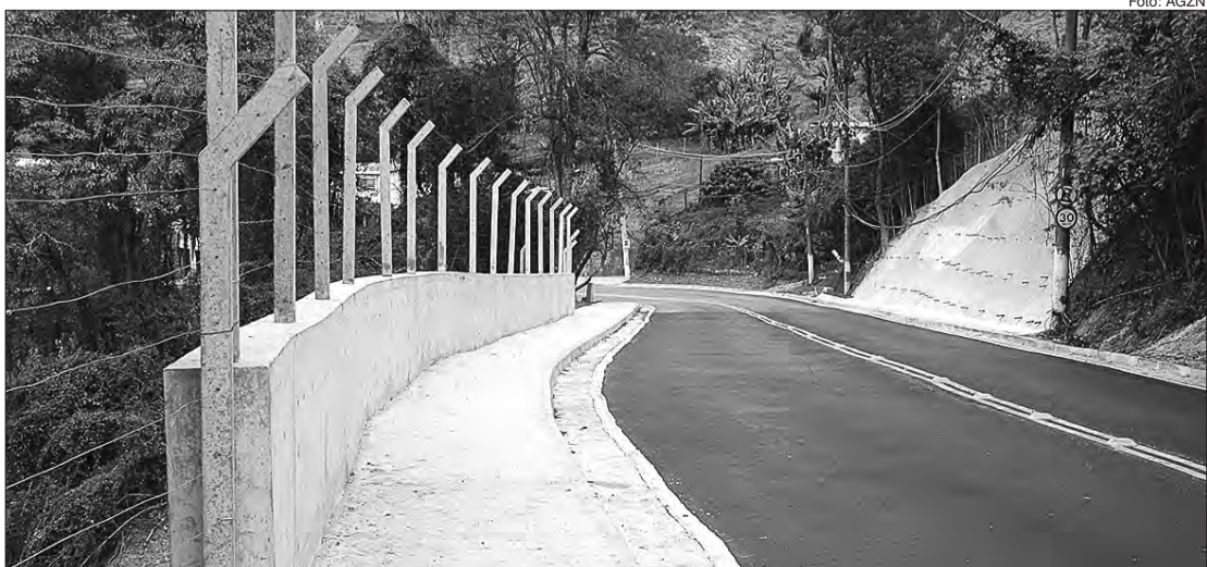
Obras na Avenida Cel. Sezefredo Fagundes são entregues no prazo previsto
