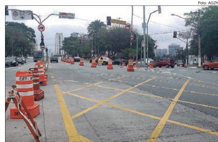
Ponte do Limão tem suas obras concluídas e tráfego volta ao normal neste sábado (18)
