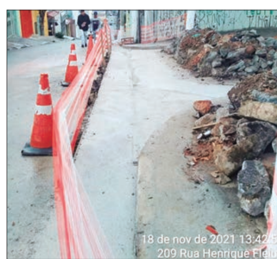
Obras do sarjetão na Rua Henrique Fleiús
