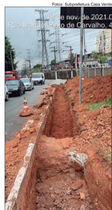
Obras iniciadas para o Jardim de Chuva da Nossa Senhora do Ó
