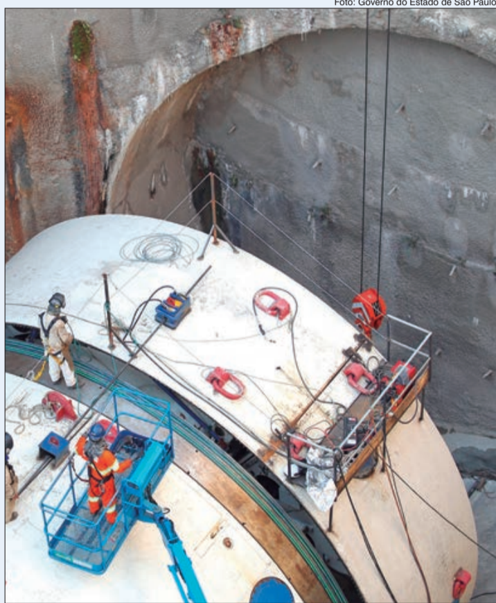
Obras da Linha 6-Laranja do Metrô utilizam técnicas modernas para a construção dos túneis
