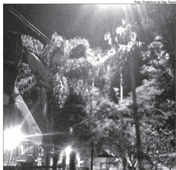
Poste em Praça no bairro do Jaçanã é revisado e volta a iluminar o local
