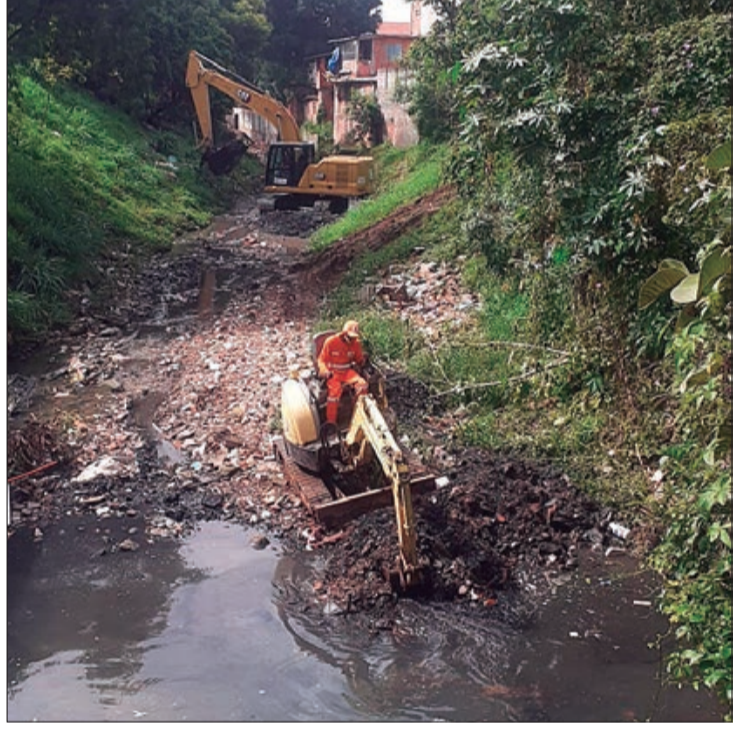
Apesar das chuvas, os trabalhos não param
