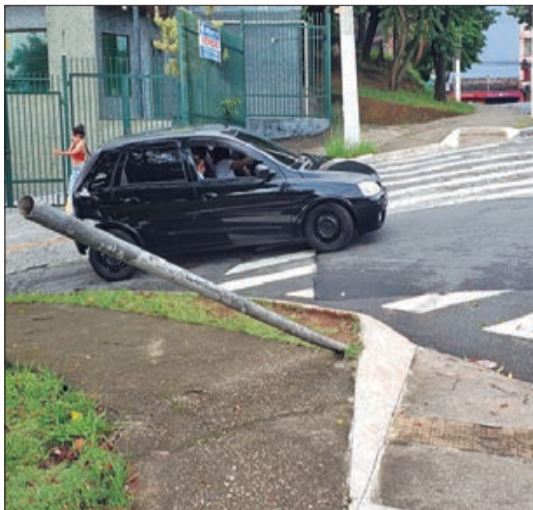
Poste caído entre a Avenida Luiz Dumont Villares e a Rua do Tramway
