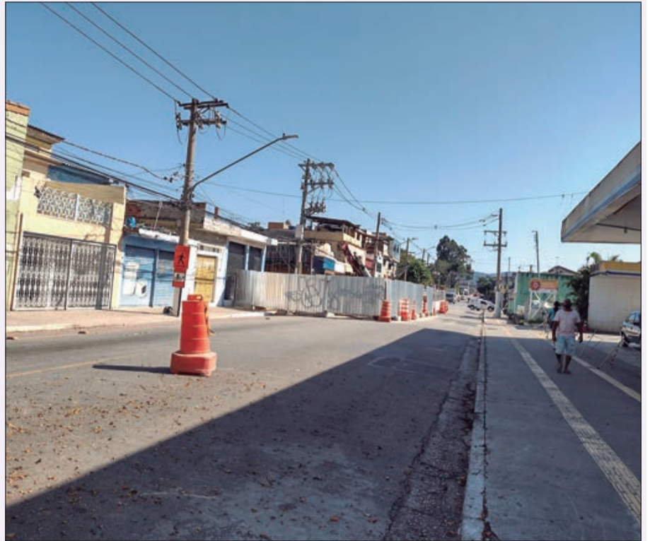
Obras emergenciais na Avenida Edu Chaves levam a interdição parcial da via
