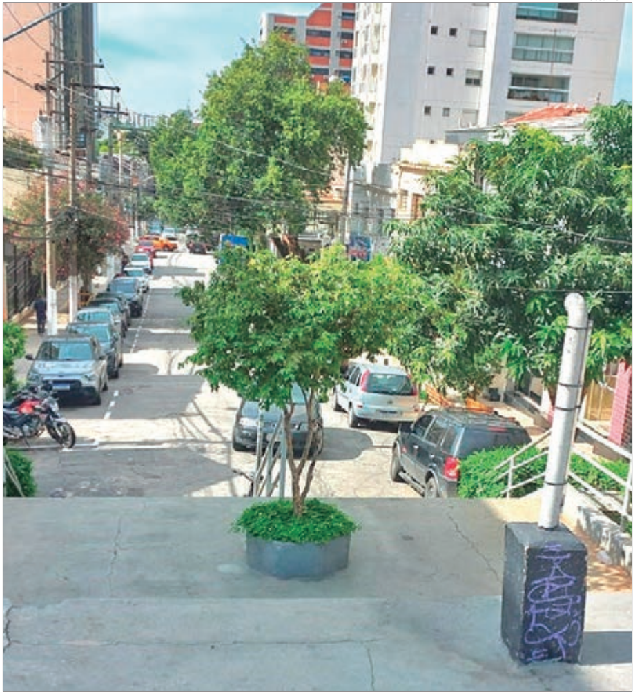
Escada entre as ruas Alfredo Pujol e Salete sem parte de seu corrimão
