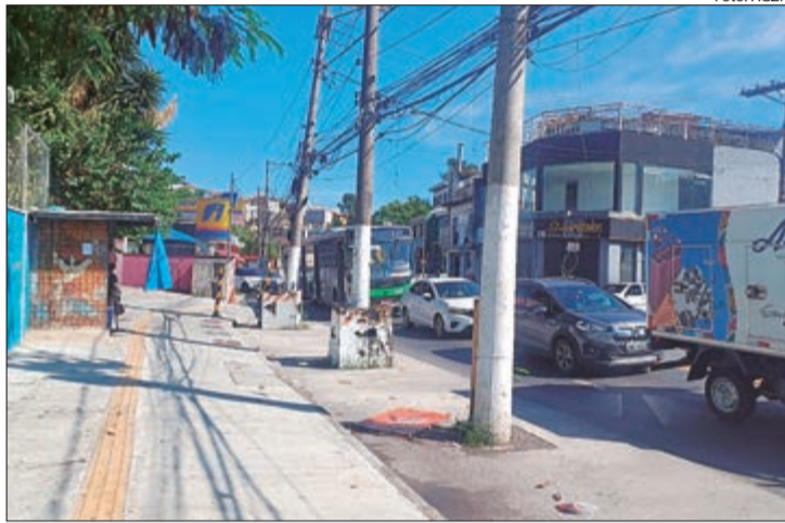
Avenida Imirim em obras tem pontos com calçadas recuadas, mas os postes ainda não foram reposicionados
