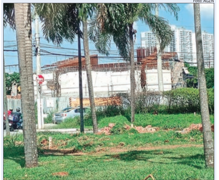
Até o momento o trânsito não foi afetado pela obra, que segue acelerada na região da Lapa, agora pelo lado de Pirituba
