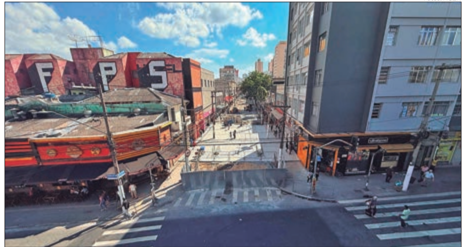
Santana já apresenta alterações a partir das obras do Boulevard da Rua Leite de Moraes
