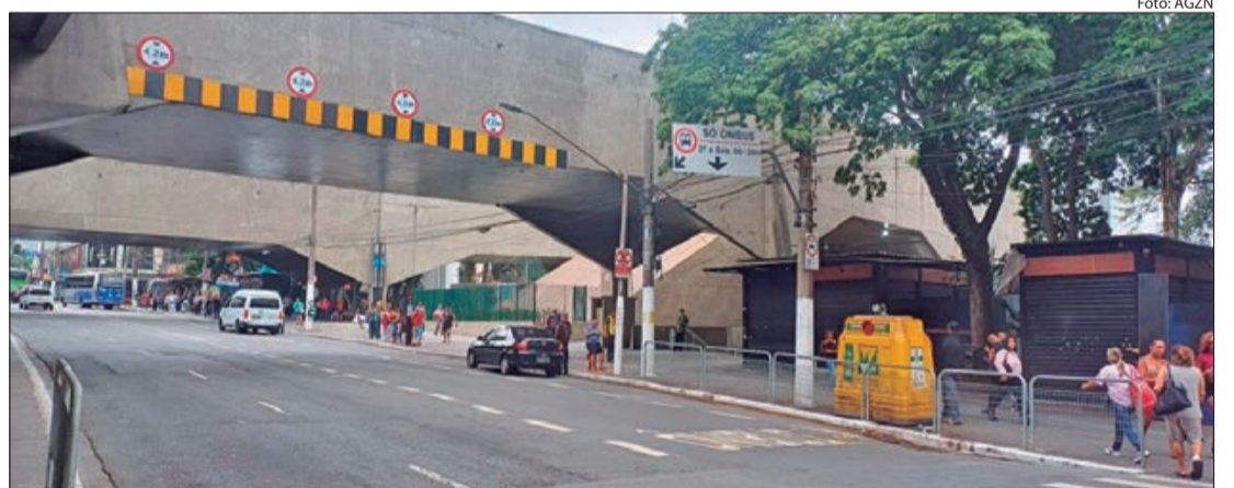
Terminal de Ônibus Santana é um dos principais da região, mas segue com diversos problemas de segurança e estrutura
