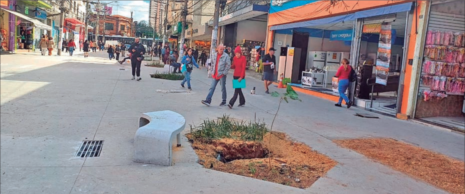
Boulevard da Rua Leite de Moraes está com sua estrutura concluída, porém ainda deve receber ajustes e aperfeiçoamentos
