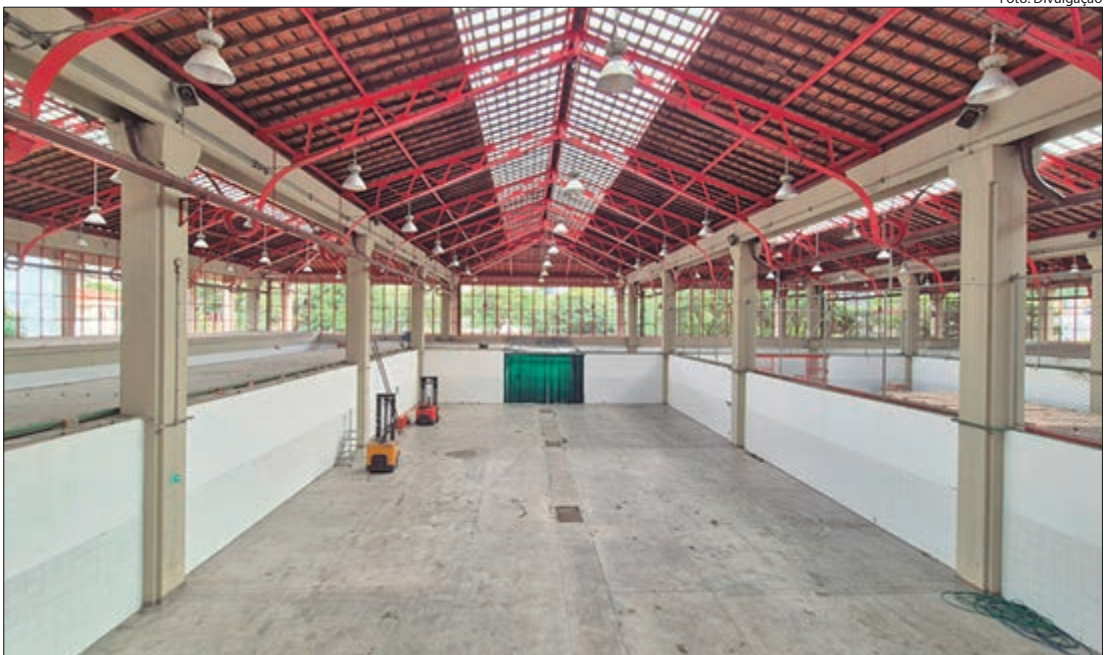
Após revitalização, Banco de Alimentos de Vila Maria recebe câmara fria, ampliação de lugares no auditório e melhores condições para preservação de alimentos
